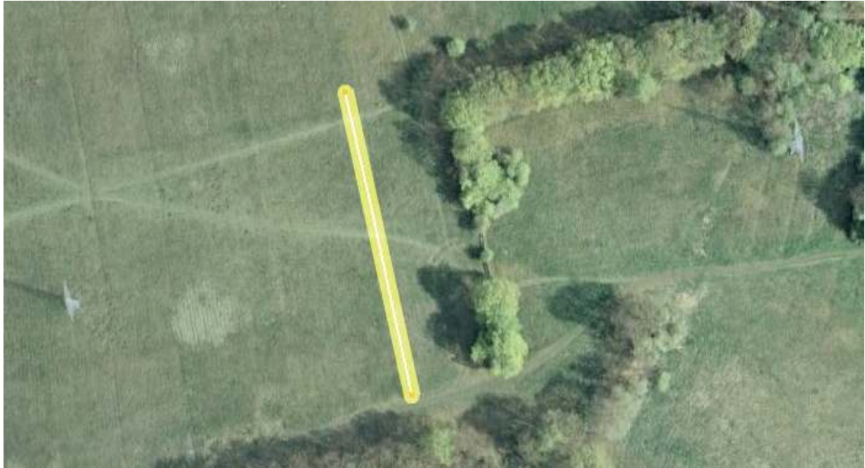
Luftbild: FL110_7, 110 kV-Freileitung
