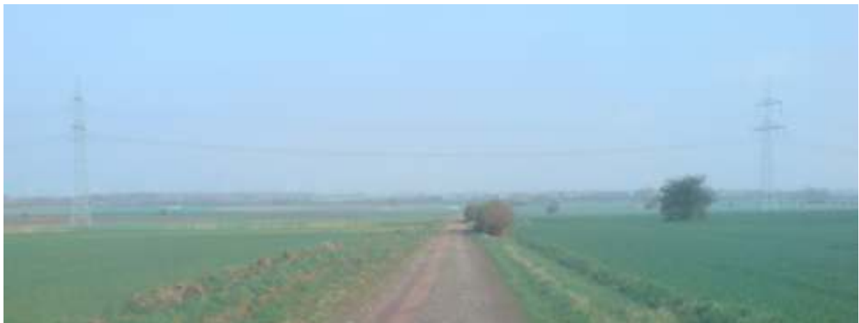
Foto: FL380_1a, Blick von Süden
