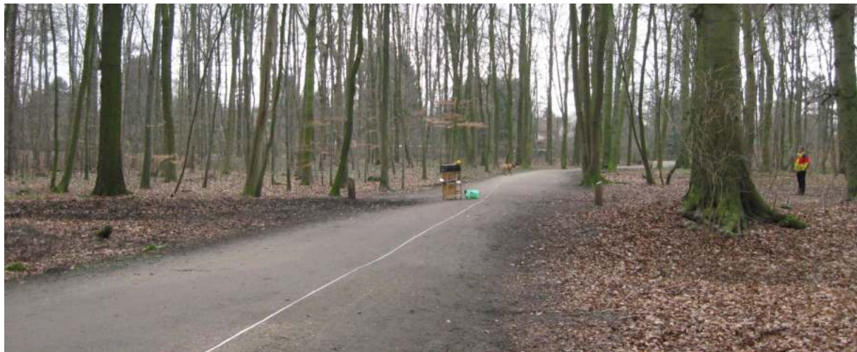
Foto: EK110_4, Blick von Norden, das Erdkabel folgt einem quer zum Fußweg verlaufenden Reitweg und kreuzt den Messweg an der Stelle des Messwagens
