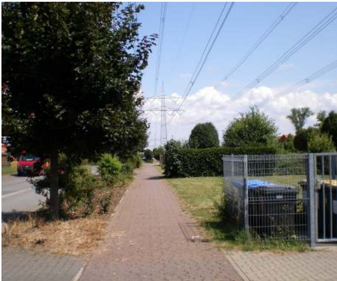
Foto: FL380_2, Blick von Süden in Trassenrichtung, der Messweg 1 verläuft hinter der nächsten Hecke nach Rechts und Links und der Messweg 2 parallel dazu vor dem Mülltonnenplatz (vorne im Bild)
