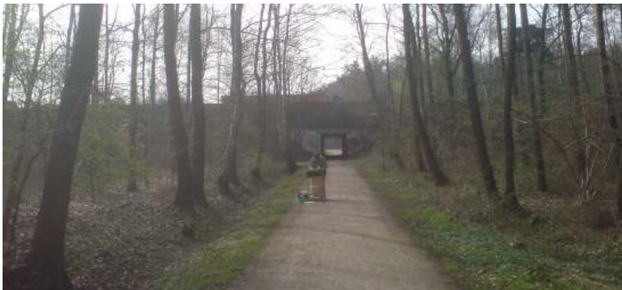
Foto: EK110_1, Blick von Norden, die 110 kV-Erdkabeltrasse verläuft auf der östlichen Seite unter dem Waldweg, der Messweg erstreckt sich nach West und Ost in den Wald hinein
