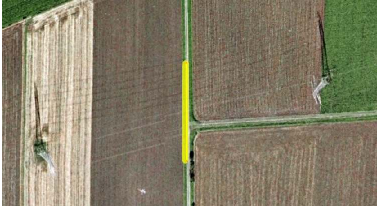
Luftbild: FL380_1a, 380 kV-Freileitung, der Messweg verläuft am linken Rand des Feldweges, der die Trasse kreuzt
