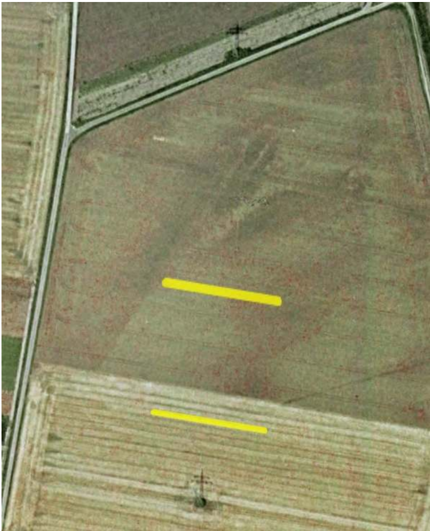
Luftbild: FL110_4a, 110 kV-Freileitung, Messweg 1 verläuft etwa am Ort des größten Durchhanges, aufgrund unterschiedlicher Masthöhen nicht genau in Spannungsfeldmitte, Messweg 2 etwa 55 m vom Mast 1, dem Mast mit den niedrigeren Leiterseilaufhängen
