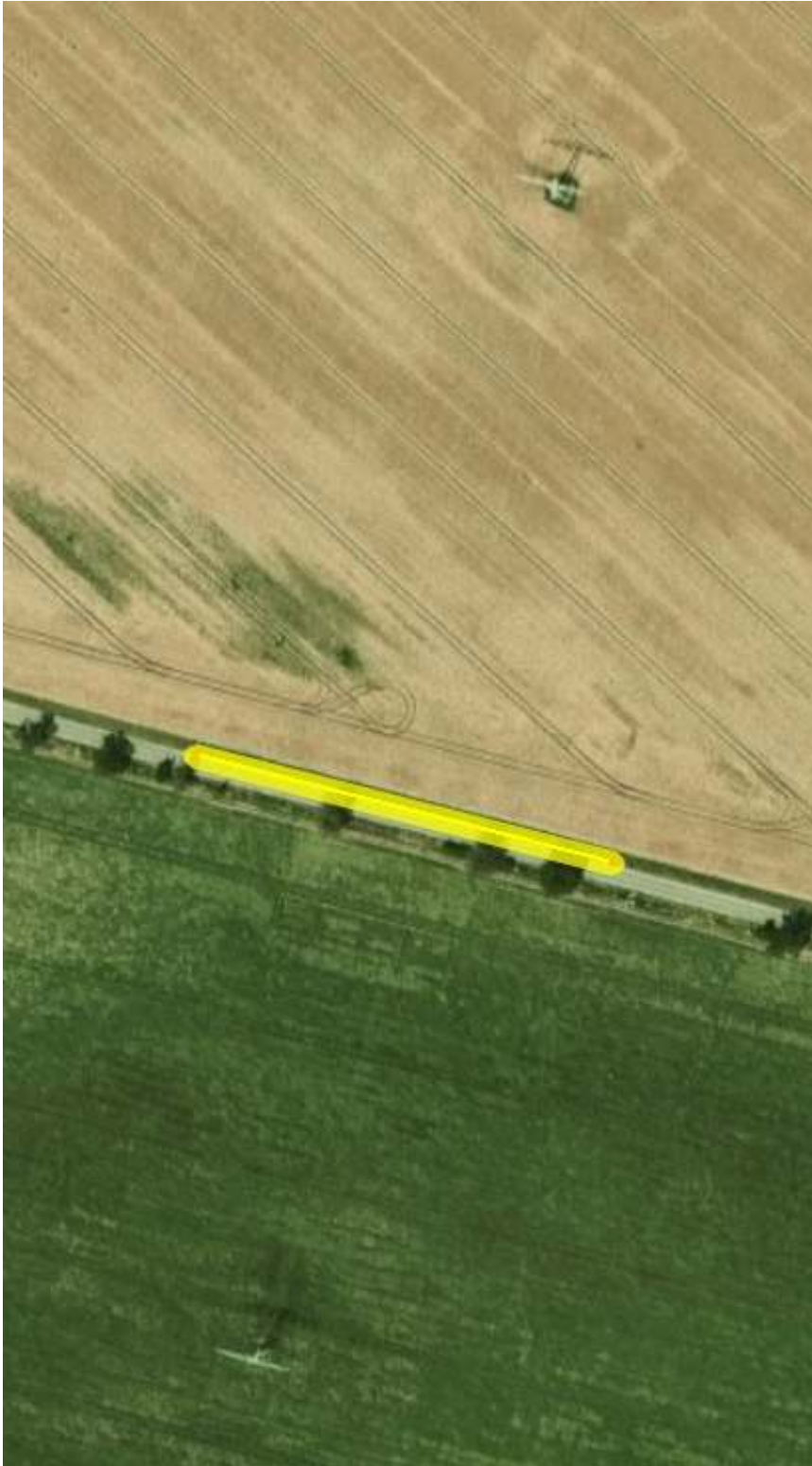
Luftbild: FL110_5, 110 kV-Freileitung, der Messweg verläuft auf dem nördlichen Randstreifen neben der Straße, die die Trasse kreuzt
