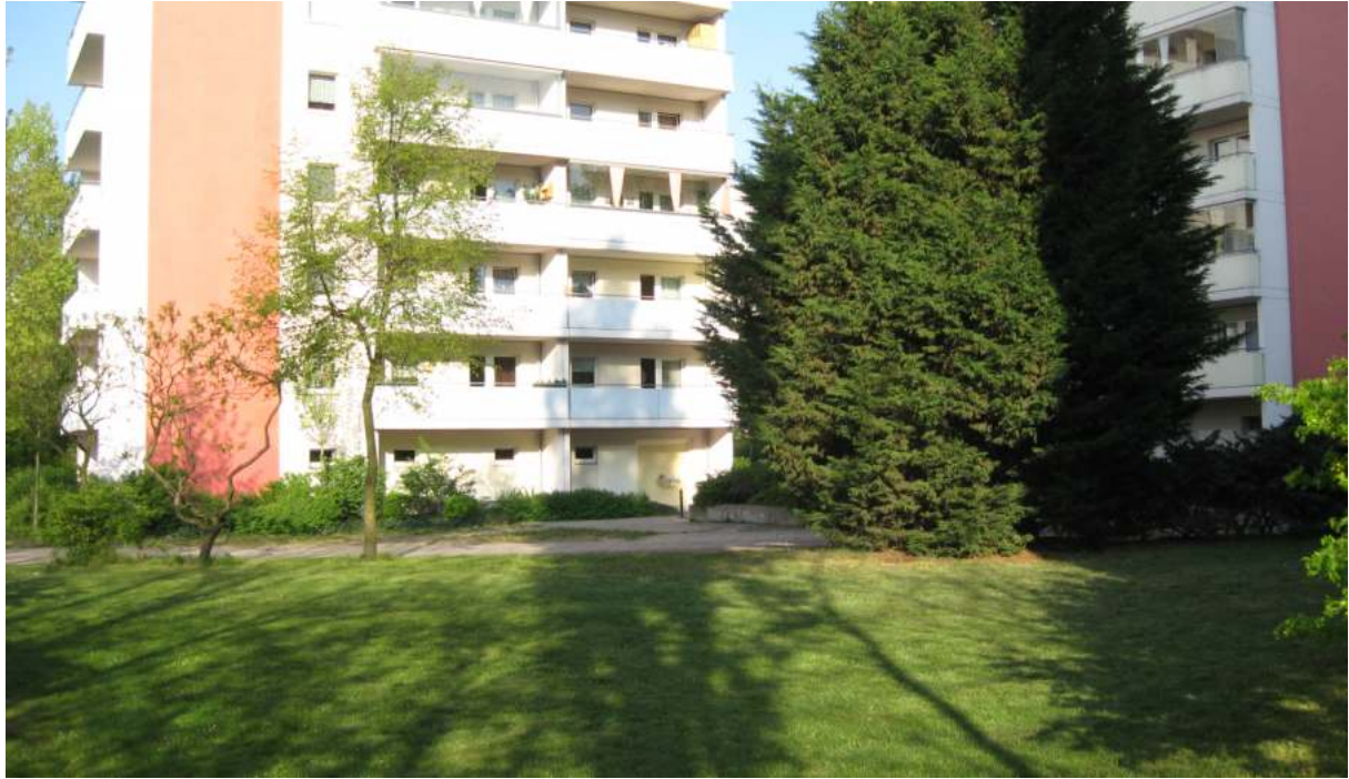
Foto: EK380_3, Blick von Osten entlang des Messweges, der Tunnel verläuft in über 30 m Tiefe (von links nach rechts) an der Grenze zwischen der Wiese und dem Fußweg, im Erdgeschoss hinter der Front an der rechten Ecke des Hochhauses, auf das der Messweg zuläuft, befindet sich eine Magnetfeldquelle, sehr wahrscheinlich ein Transformatorraum mit der Hochhaus-Stromverteilung
