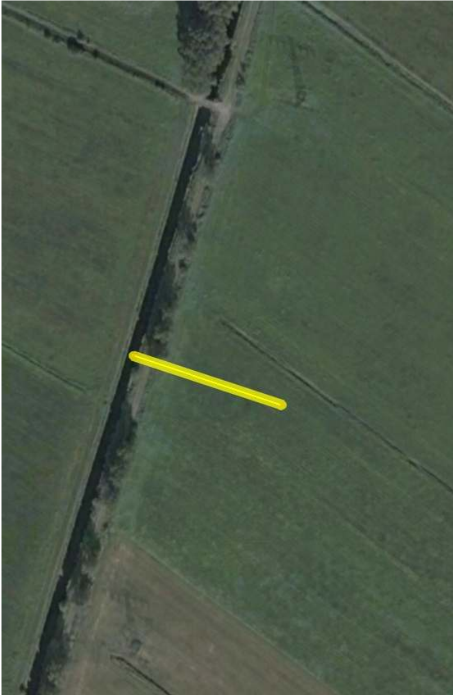
Luftbild: FL220_1, 220 kV-Freileitung
