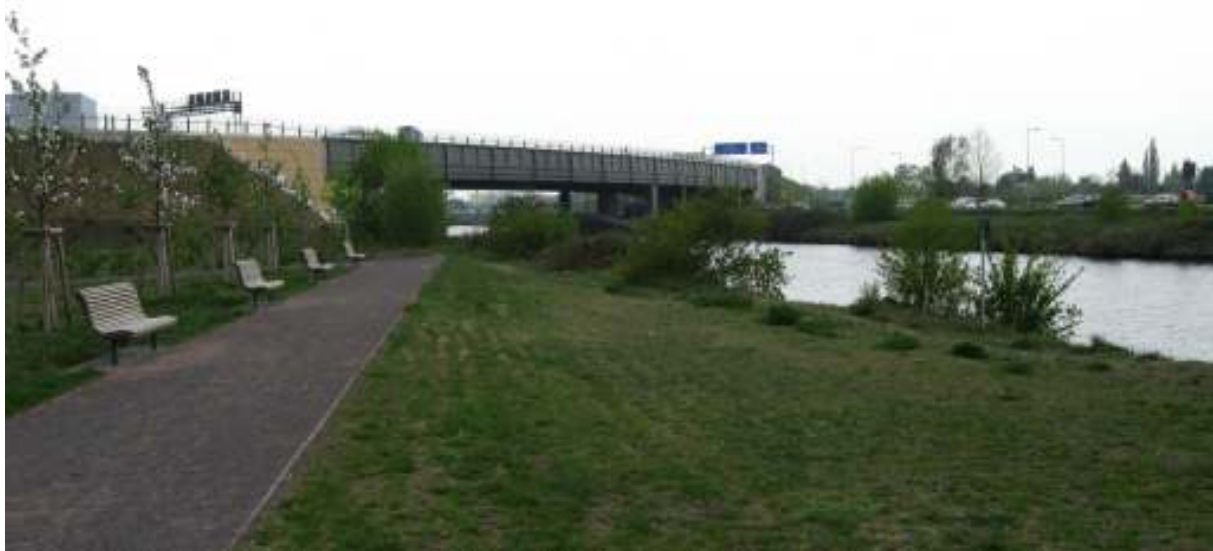
Foto: EK220_1, Blick von Westen, der Messweg verläuft (senkrecht zum Erdkabel) parallel zum Fußweg auf dem Wiese vor den Büschen
