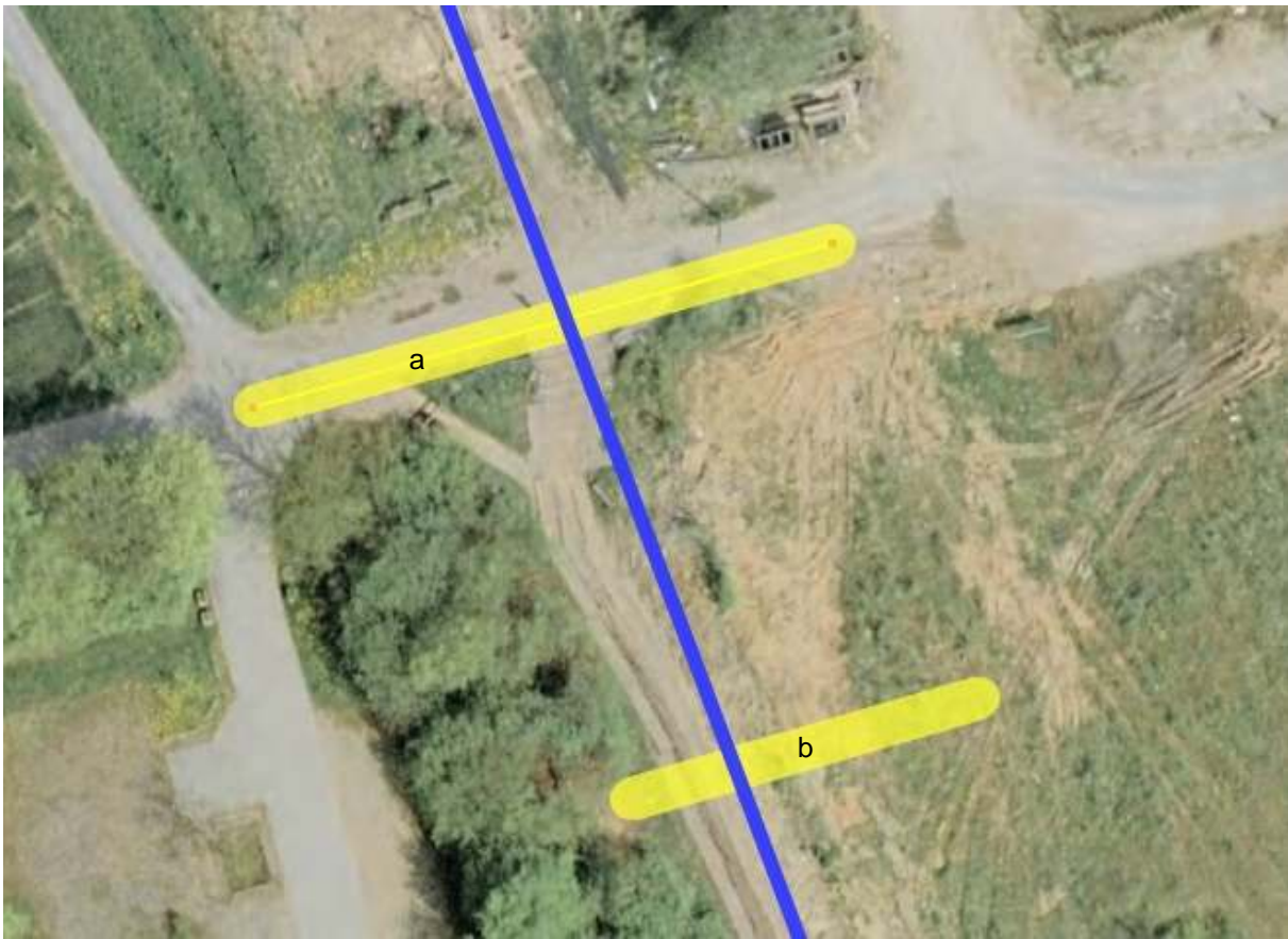
Luftbild: EK110_2, 110 kV-Erdkabeltrasse, die Kabeltrasse verläuft von Nord nach Süd, parallel zu dem Radweg
